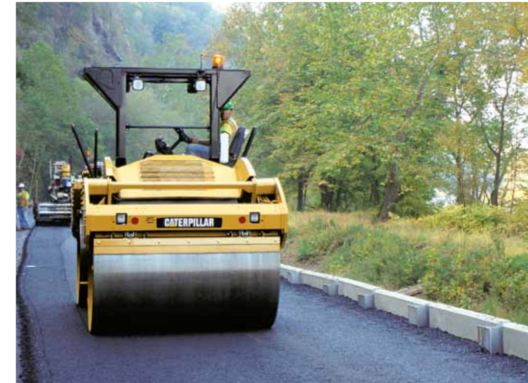
↗ Versa-Vibe-Maschinen erreichen den gewünschten Verdichtungsgrad in weniger Übergängen.
