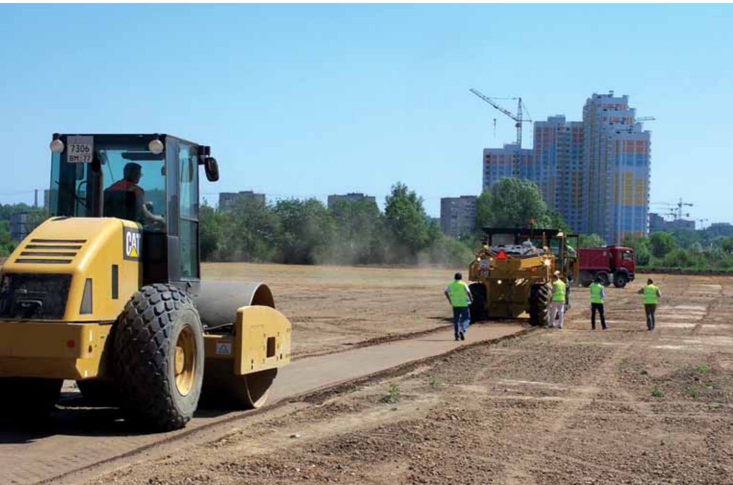
⤴ Hinter dem Cat RM500 Motorgrader auf der 30 Hektar großen Baustelle bei Moskau arbeitet die Cat CS533E Boden-Vibrationswalze.
