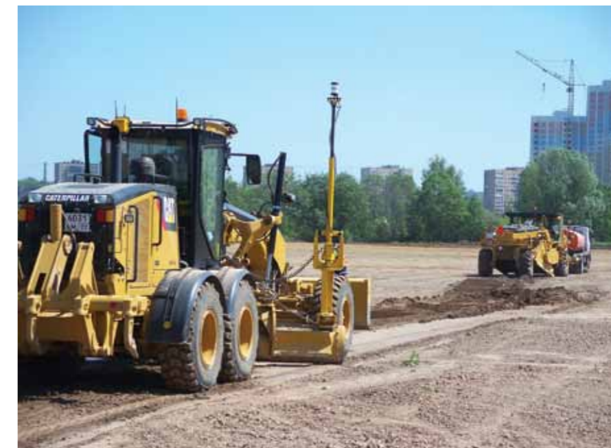
Ein Cat-Motorgrader folgt dem RM500 Bodenrecycler mit voraus fahrendem Tankwagen.
