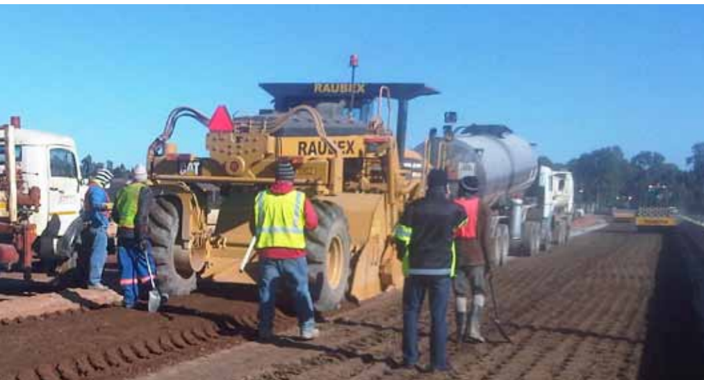
Der Bauleiter bestellt Emulsion und Zement als Zuschlagstoff zur Stabilisation ^
