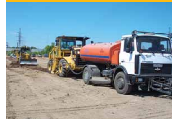
⤴ Ein Cat-Motorgrader nivelliert den Boden hinter dem RM500 Bodenrecycler zur nachfolgenden Verdichtung
