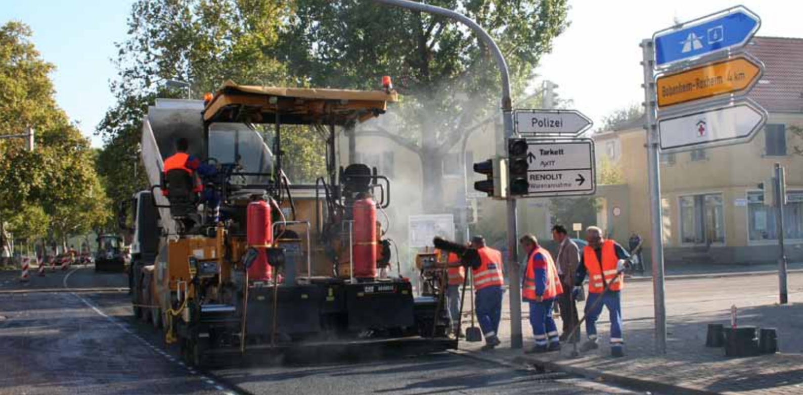
Für gleichmäßige Verdichtung und eine ebenflächige Straßendecke sorgt die mit Gas beheizte Einbaubohe AS 4251 C wie hier bei der Sanierung einer Straßenkreuzung in Frankenthal. ^
